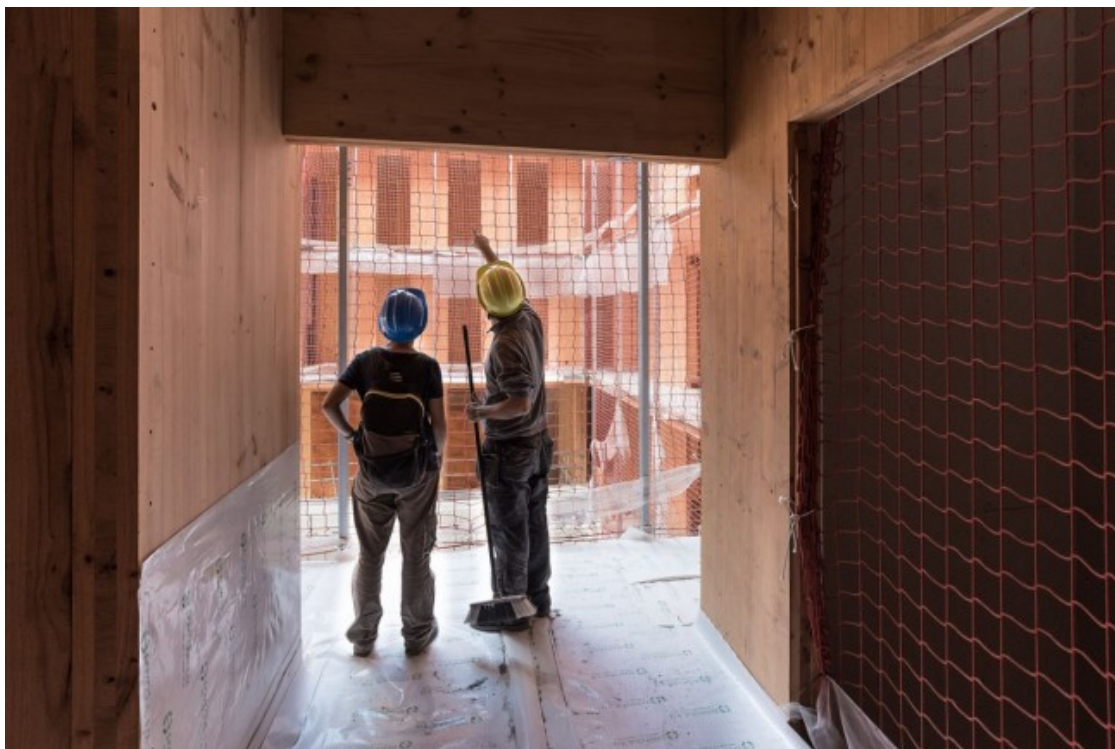
Jornada d'autoconstrucció a l'edifici de La Borda, a Barcelona Foto: Joan Andreu i Usue Belandia
