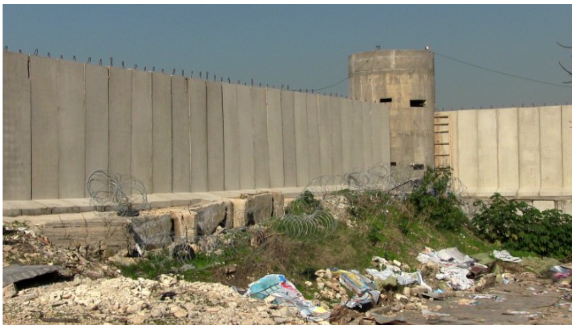
Nou mur en construcció a Ein El Hilweh Foto: Laura Arau
