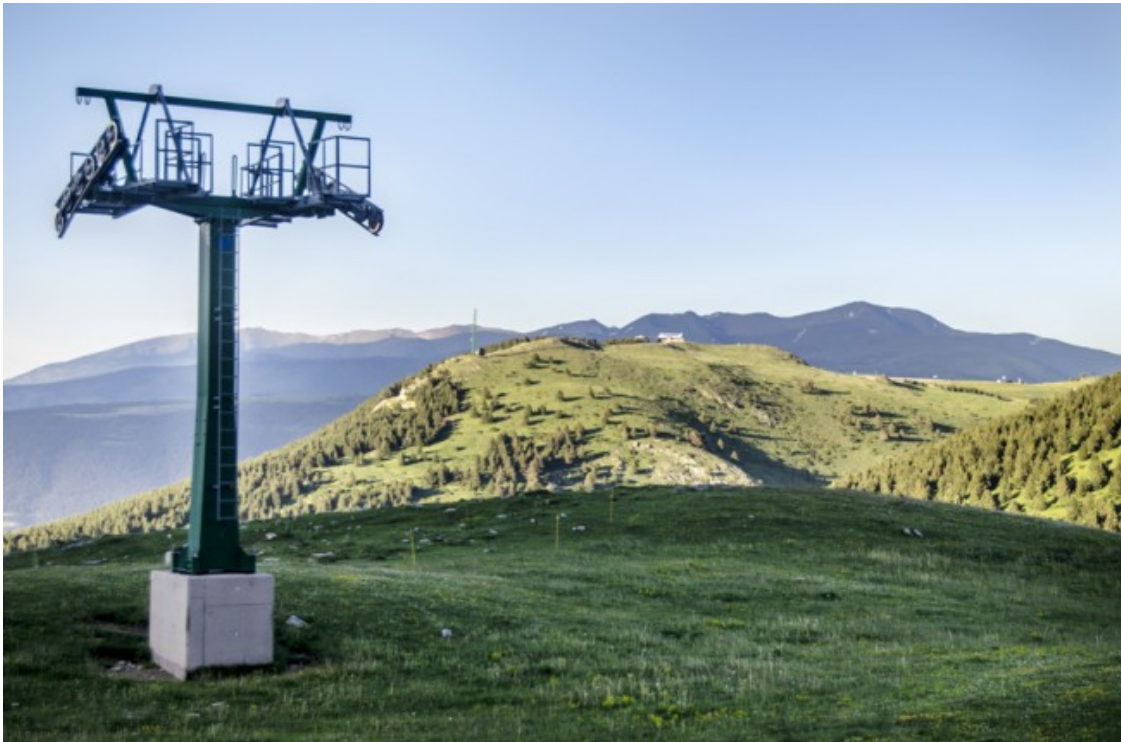
Imatge presa durant la construcció del telecadira Coll de Pal-La Molina Foto: Arnau Flores
