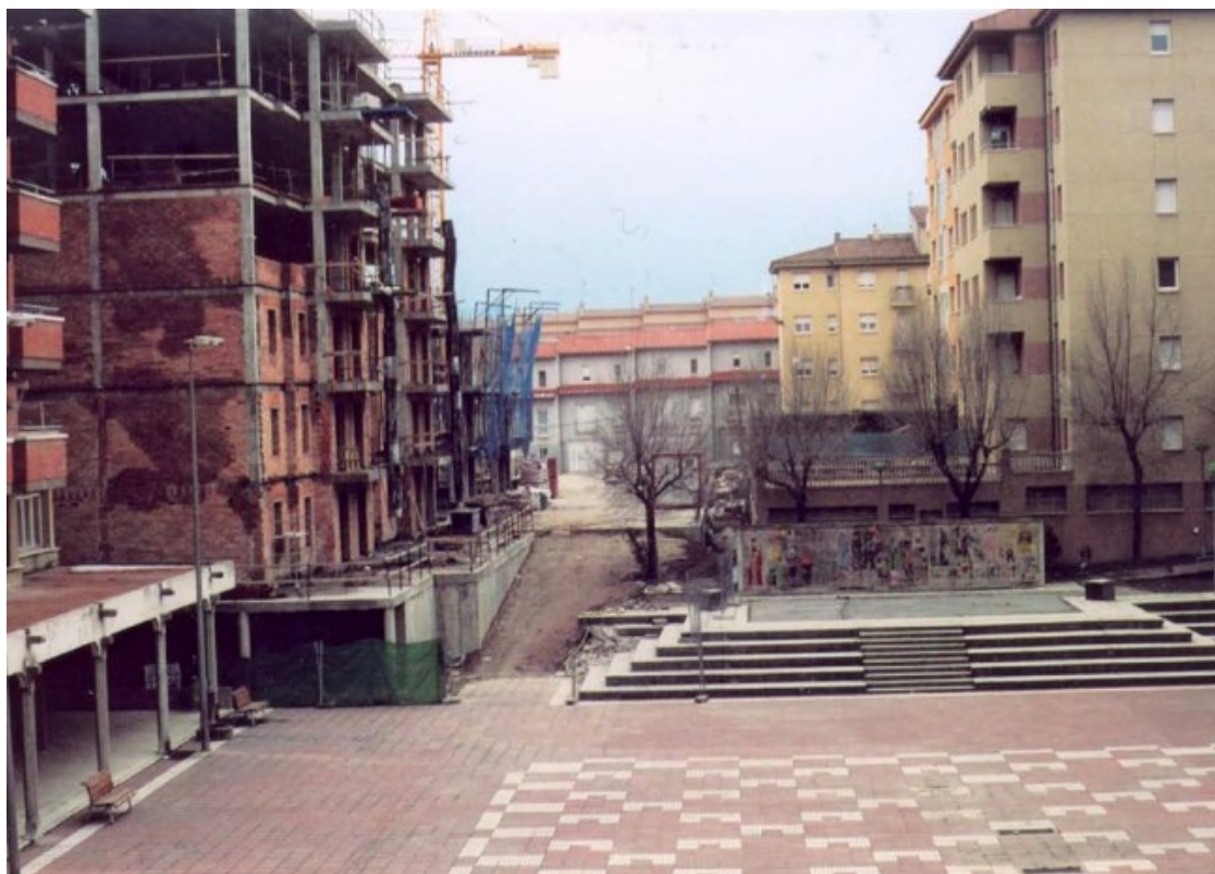
Construcció de la plaça d'Osona als anys setanta Foto: Com
