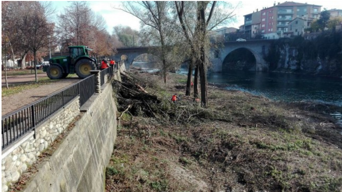
Treballs de tala dels arbres, aquest dimecres a toca del passeig del Ter de Manlleu Foto: Grup de Defensa del Ter
