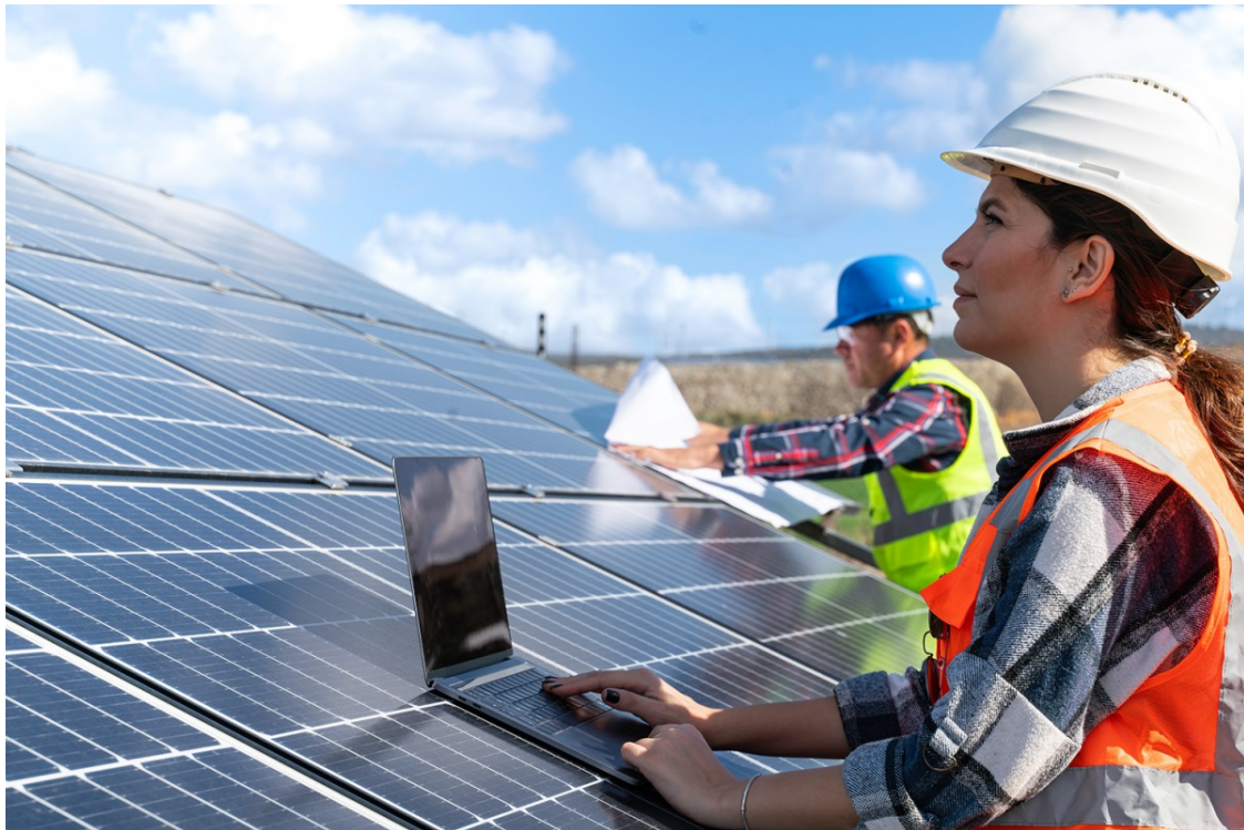
Procés d'instal·lació de plaques solars a la teulada d'un edifici
